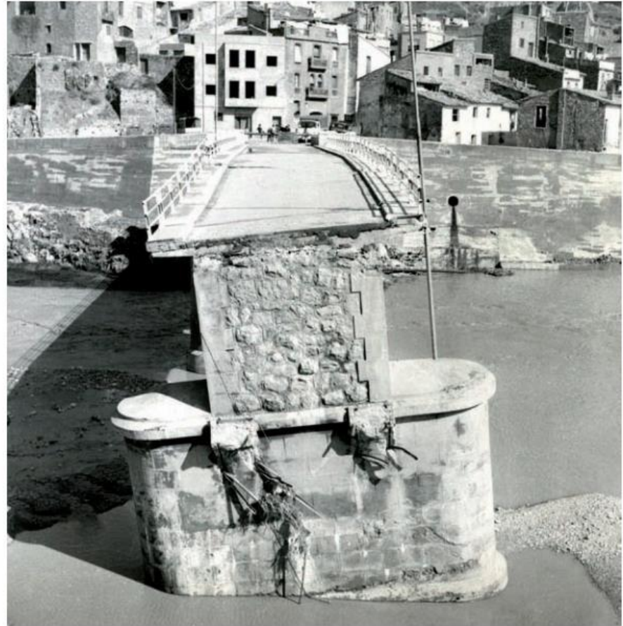
Puente de Ribesalbes (Castellón). 1967 Daños ocasionados por la crecida del 23 de octubre
